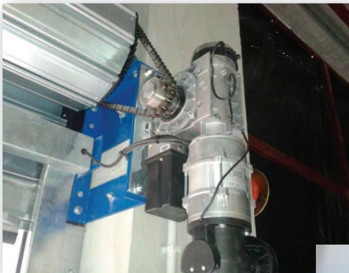
Los motores industriales (Sommer y Elektromaten) para este tipo de puertas, son extremadamente robustos, potentes, de bajo mantenimiento y elevada durabilidad, ya que su funcionamiento de ataque al eje, no requiere de ningún tipo de compensación para el peso de la puerta.
